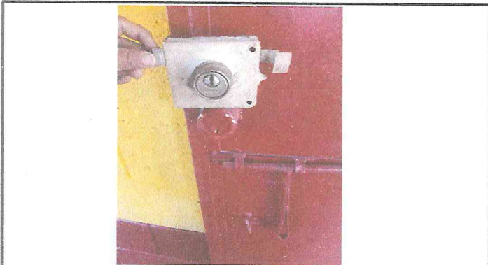
Foto 3: SUSTITUCION DE CHAPAS
