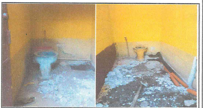
Foto 6: SUSTITUCION DE INODOROS
