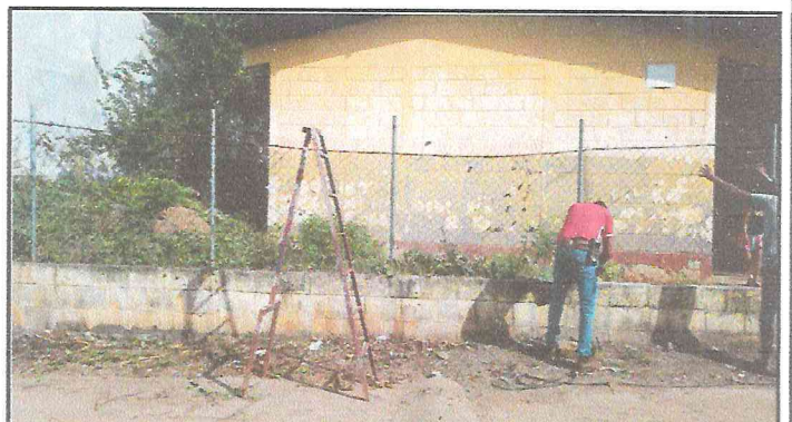
Foto 4: REPARACION DE MURO PERIMETRAL DE BLOCK
