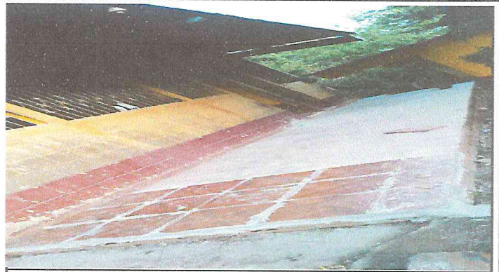
Foto 2: REPARACION DE BANQUETAS DE CONCRETO
